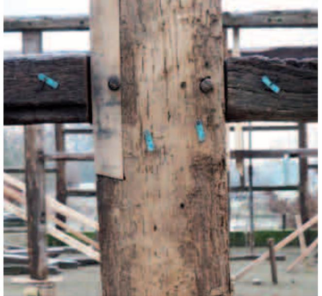
**Marken an allen Knotenpunkten helfen das Puzzle zu lösen. Gut zu erkennen: die Ausbesserung einer schadhaften Stelle.**
