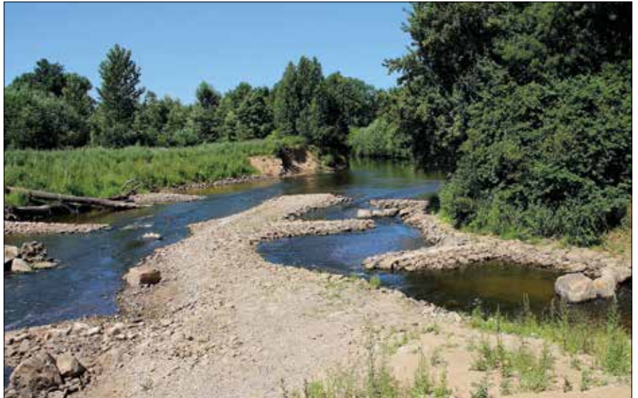
Steinschüttung an der Einmündung der Hessel in die Ems
