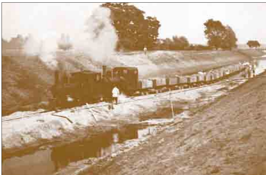
Ausbauarbeiten westlich von Warendorf 1932 – 1935
