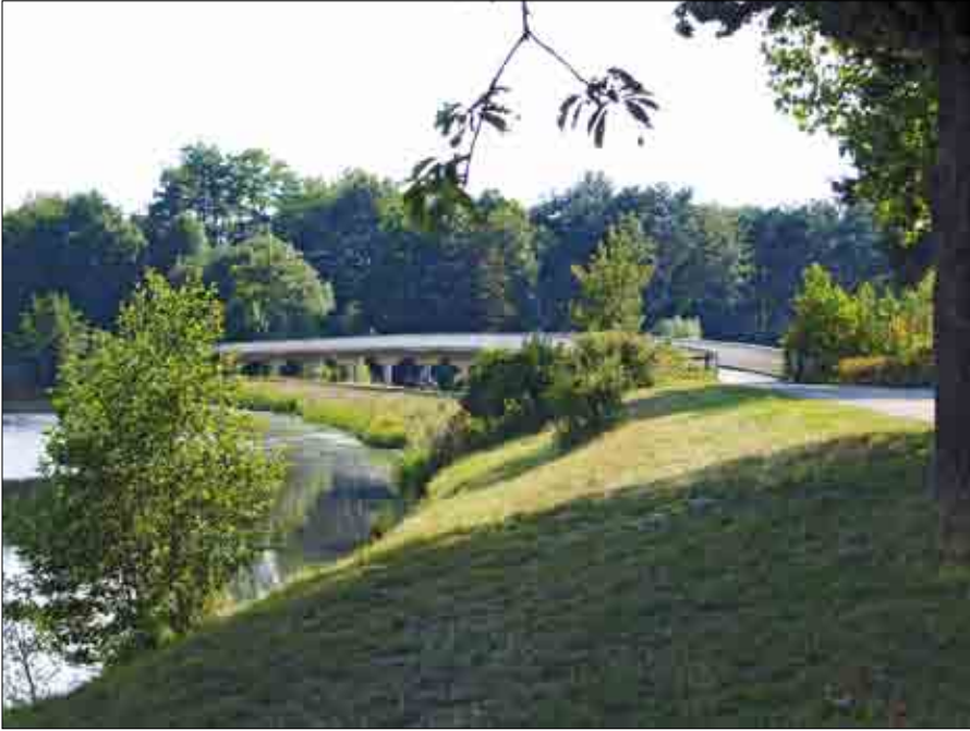
Brücke und Überlaufschwelle am östlichen Ende des Emssees
