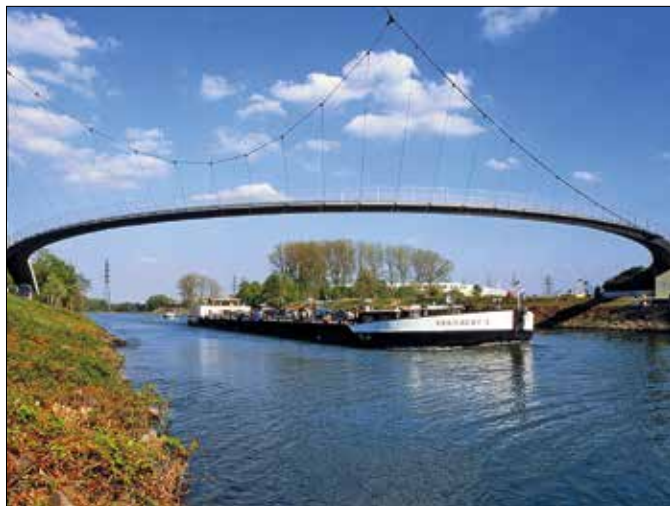
Die elegante Grimbergbrücke führt seit 2009 Fußgänger und Radfahrer über den Rhein-Herne-Kanal
