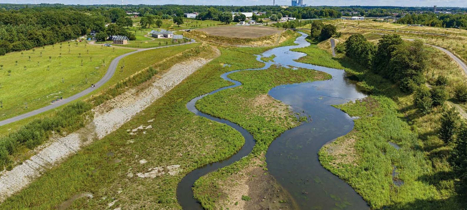
Abwasserfrei mäandrierende Emscher in Castrop-Rauxel 2025 – WassererlebnisPark Emscher, Blick flussaufwärts (Emschergenossenschaft/Lippeverband)
