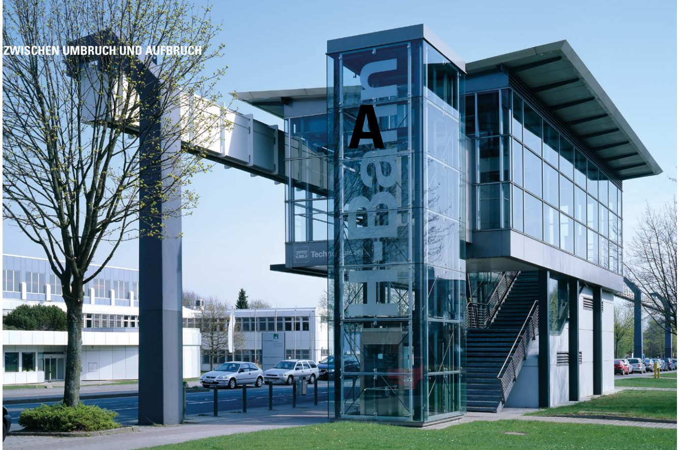
Station der Schwebebahn (H-Bahn) Dortmund, Emil-Figge-Straße – vollautomatisch gesteuerte Großkabinenbahn zwischen der Technischen Universität Dortmund und dem Technologiepark, Inbetriebnahme 1984, Hersteller: Siemens AG
