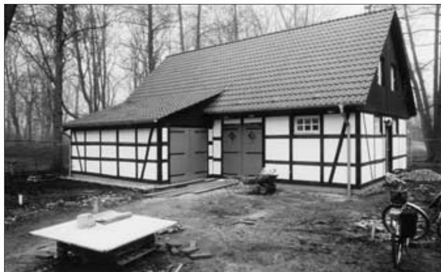
Fertiges Fachwerkhaus als Teil des Ensembles vom Heimatmuseum
