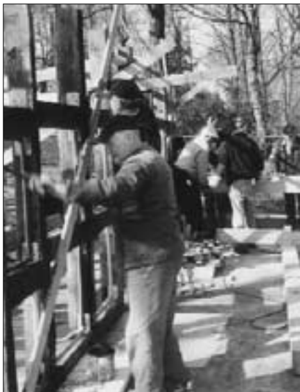
Zimmermannsarbeiten (Fotos: Heimatverein Marl)
