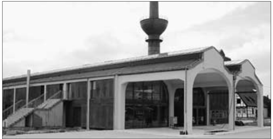
Die markante Gempt-Halle in Stahlbeton wenige Tage vor ihrer offiziellen Eröffnung. Im Hintergrund der Wasserbehälterurm, der vor einigen Jahren schon aufwendig restauriert wurde, rechts das alte Pastorenhaus in neuem Fachwerk. (Photo: Herringslack)
