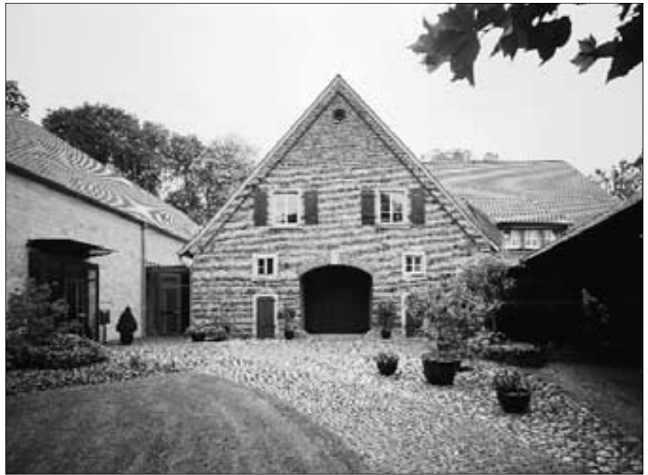
Ernsting Stiftung Alter Hof Herding, Blick auf die ehemalige Tenne, heute Konzertsaal
