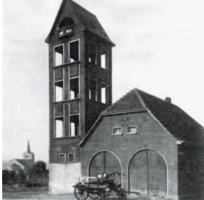
Eine Ansicht des Steigerturms von 1914 mit Spitzdach, Foto um 1932
